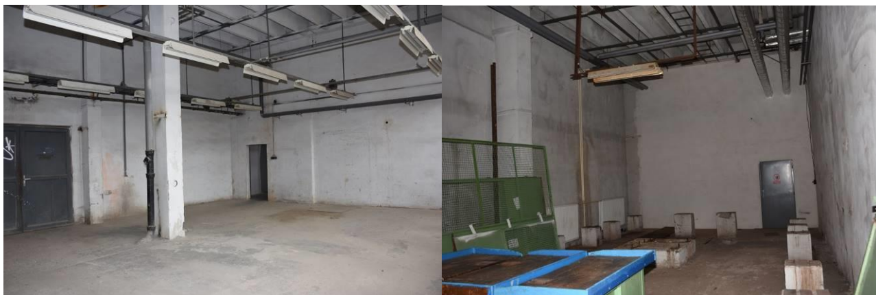
Obr.: Suterénní prostory před rekonstrukcí...
