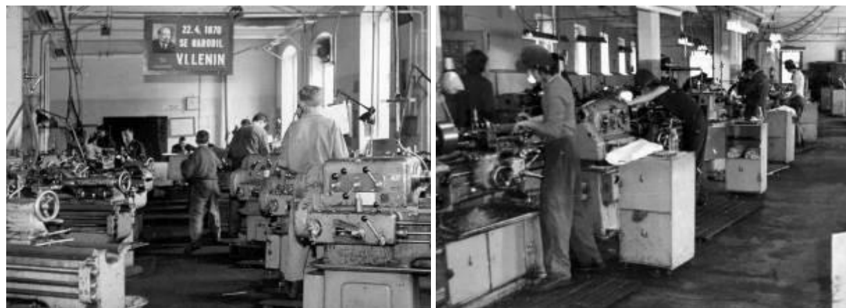
Obr.: Práce ve školních dílnách dřívě
